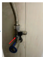
4. Nối van cấp nước đầu vào với ống dẫn nước máy. Lọc mớ men xoắn của đai ốc là khoảng 3,2N/m.
