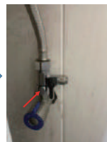
5. Lắp van cấp nước vào đường ống nước máy. Lực mở men xoắn của đai ốc là khoảng 3,2N/m.
