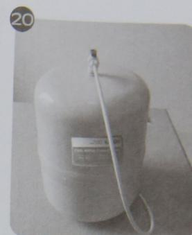
Cung cấp lại nguồn điện cho máy nhằm tiến hành xả rửa toàn bộ hệ thống máy qua vòi cỗ ngỗng để loại bỏ các chất bảo quản của vòi. Thực hiện xả trong vòng 5 - 10 phút. Sau đó đóng vòi cỗ ngỗng lại và mở van bình áp để nước tinh khiết chảy vào bình chứa.
